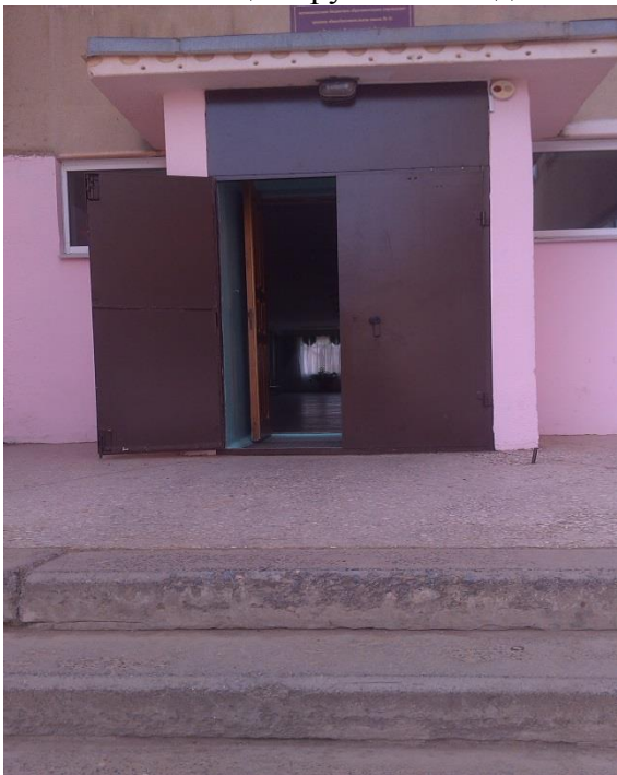
Фото 8 Лестница наружная. Входная площадка (перед дверью)
